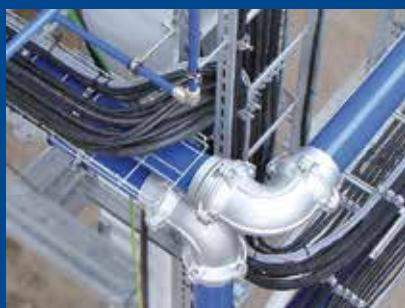
De nada nos sirve tener el mejor compresor del mercado, que nos proporcione un alto rendimiento y ahorre energía, si en la red de distribución de ese aire, tenemos fugas o no está correctamente dimensionada y se produce una caída de presión.
